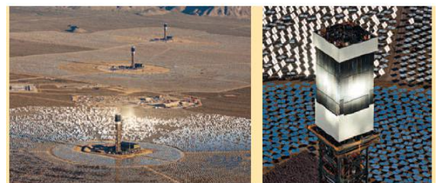
Gambar 3. Pembangkit Listrik Thermal Tenaga Surya (PLTTS)
