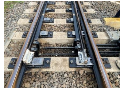
Gambar 2 Wesel kereta api dan lidah wesel yang dicat putih
