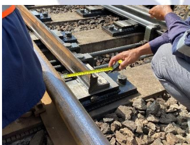
Gambar 7 pengukuran jarak lidah wesel dengan rel lantak
