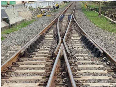
Gambar 1 Rel 52 yang dipakai di kawasan Stasiun Ciamis
