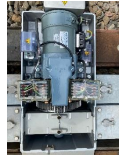
Gambar 2 Penggerak wesel tipe BSG 9
