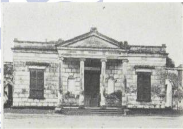
Gambar 3 Atap perisai/limas bangunan arsitektur Sumber : Oud Soerabaia
