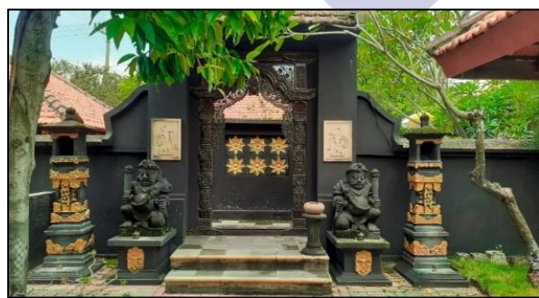
Gambar 4. Pintu masuk menuju jeroan atau utama mandala
