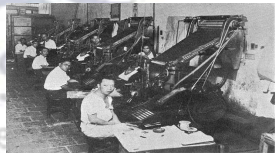
Gambar 3.3 Pekerja Sin Po Mengoperasikan Mesin Cetak Linotype
