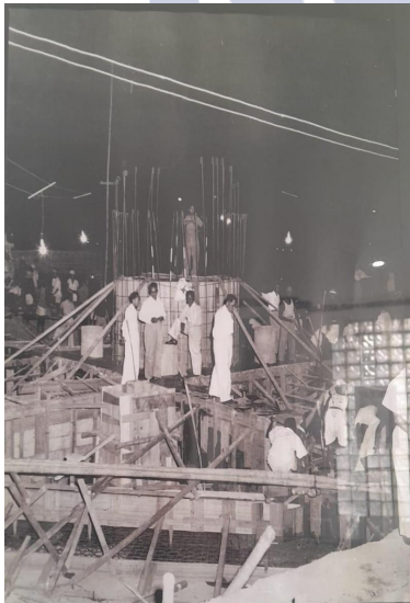
Gambar 3. Proses Pembuatan Pondasi Tugu
