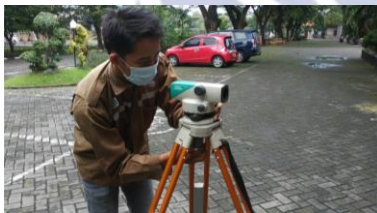
Gambar 7. Pemasangan Pesawat Waterpass (Sumber: Dokumen Pribadi)
