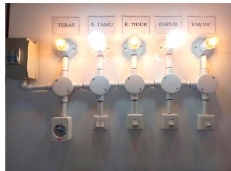
Gambar 6. Alat Peraga Instalasi Listrik Satu Phase Saat Dinyalakan
