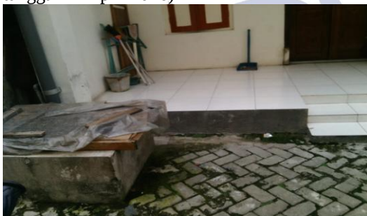
Gambar 4.11 Sumur di depan rumah Ibu Djuwita
