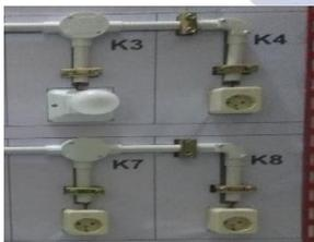
Gambar 15. Gambar kotak kontak
