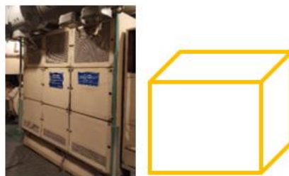
Gambar 10. Balok pada Motor Listrik
