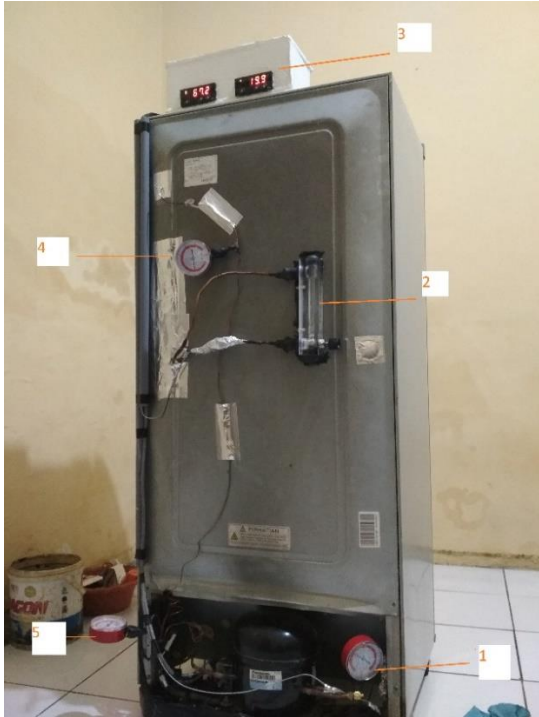
Gambar 3 Hasil pemasangan alat instrumentasi
