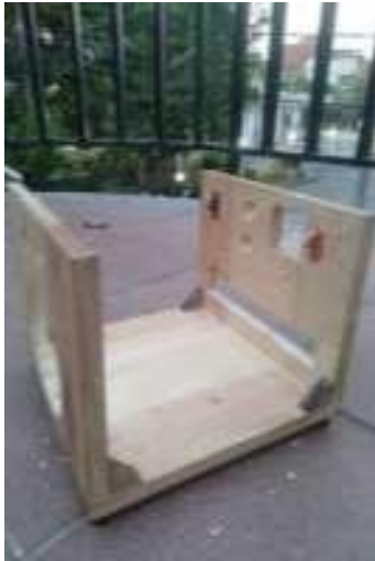
Gambar 7: Pembuatan Casing Trafo
