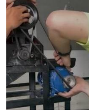
Gambar 6. Pemasangan Sistem Transmisi
