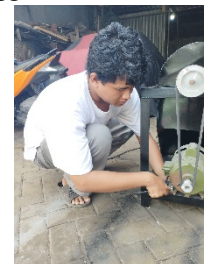
Gambar 5 Pemasangan Motor Listrik
