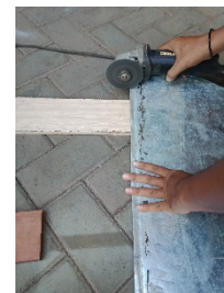
Gambar 4 Pemotongan plat besi
