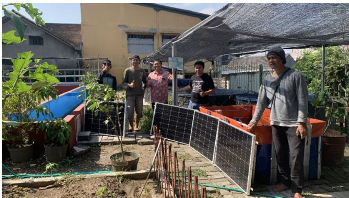
Gambar 3. Solar Panel Untuk Pompa Urban Farming
