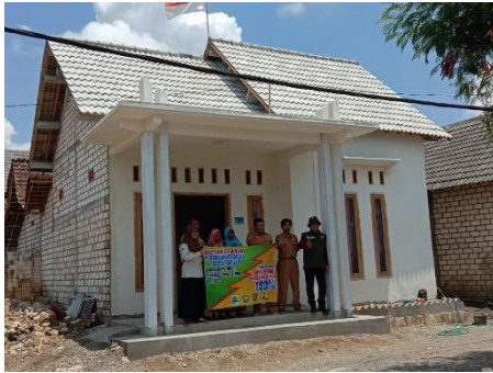
Gambar 3. Penyelesaian pembangunan rumah dengan skema swadaya
