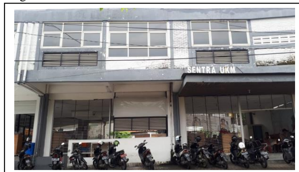
Gambar 3. Gedung sentra ukm jahit bukit barisan Sumber : Dokumentasi peneliti 2021
