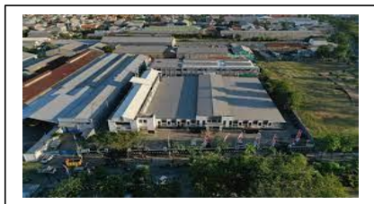
Gambar 1. Pasar Nambangan tampak dari atas setelah direvitalisasi fisik
