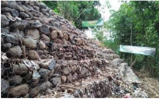
Gambar 7. Hasil Pemasangan Bronjong Kegiatan TMMD
