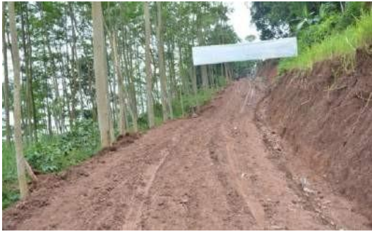
Gambar 3. Kondisi Jalan Setelah TMMD
