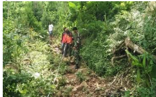
Gambar 2. Kondisi Jalan Sebelum TMMD
