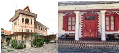
Gambar 1.7 Bangunan Gajah Mungkur dan Kampung Kemas
