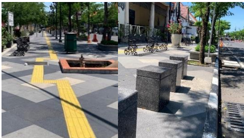
Gambar 1.4 Guiding Box dan Bollard di Jalan Basuki Rahmad
