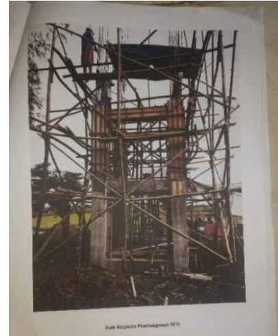
Gambar 4 Proses Pembangunan Jaringan
