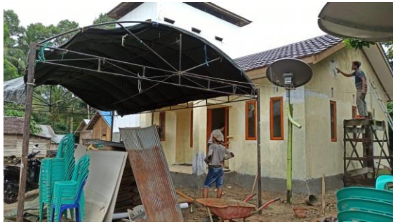
Gambar 5 Proses Pembangunan Kantor Desa Sumber : Dokumentasi Peneliti, 2014
