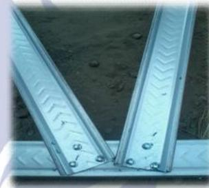
Gambar 1. Sambungan rangka atap baja ringan.
