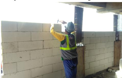
**Gambar 5. Memasang Blok Bata Ringan**
