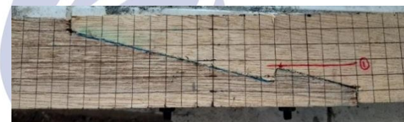
Gambar 13. Kerusakan kayu benda uji E
