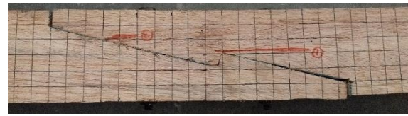
Gambar 10. Kerusakan kayu benda uji B
