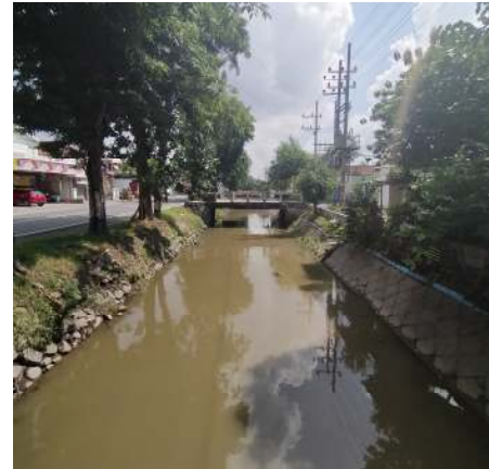
Gambar. 2 Kondisi Existing Sungai Gude Ploso (Sumber: Dokumentasi Pribadi Januari 2020)
