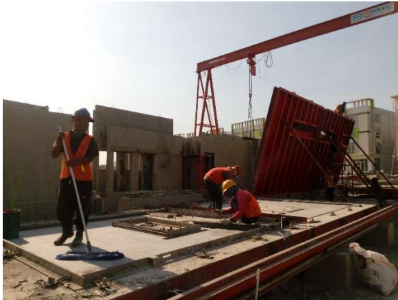
Gambar 2. Perakitan Cetakan Panel Dinding Beton Pracetak in situ (dokumentasi pribadi, 2017).
