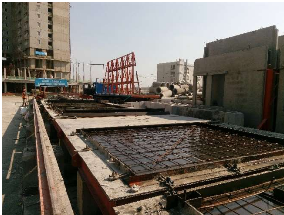
Gambar 3. Pemasangan Tulangan pada Cetakan Dinding Beton Pracetak (dokumentasi pribadi, 2017).
