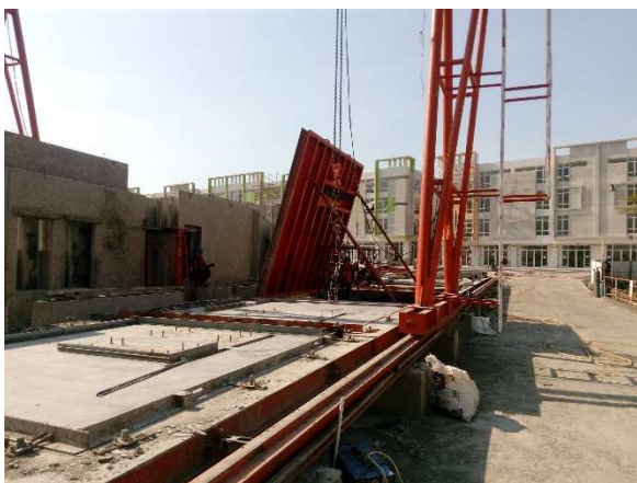
Gambar 4. Proses Pelepasan Panel dari Cetakan (dokumentasi pribadi, 2017).
