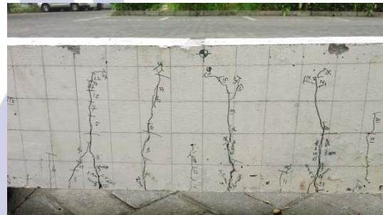
Gambar 10 Pola Retak BL.0% Sisi Timur
