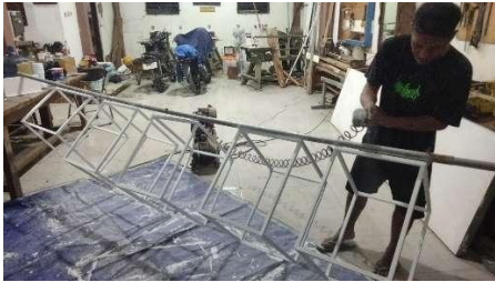
Gambar 48. Proses Pembuatan Kerangka Hollow Galvanis (Sumber: Dokumen Evita, 2025)
