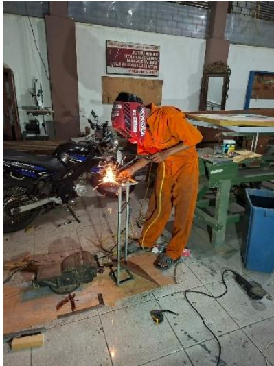
Gambar 5. Pembuatan kontruksi (Sumber: Koleksi pribadi)
