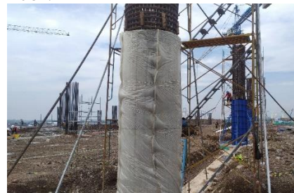
Gambar 20. Beton ditutupi menggunakan plastik
