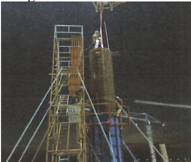
Gambar 16. Pengecoran menggunakan bucket concrete
