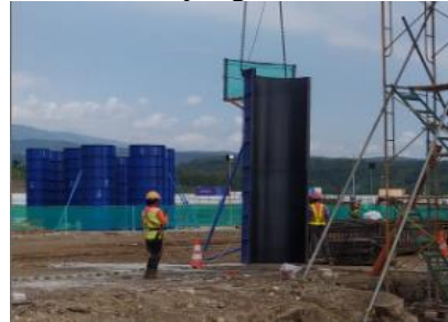
Gambar 18. Pelepasan bekisting menggunakan bantuan tower crane
