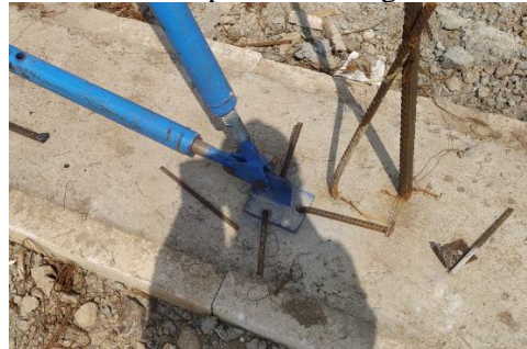
Gambar 11. Adjustable kickers av
