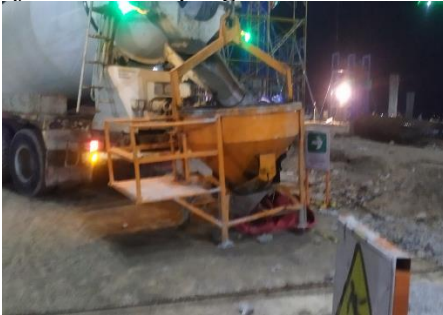
Gambar 15. Beton dituang ke bucket concrete
