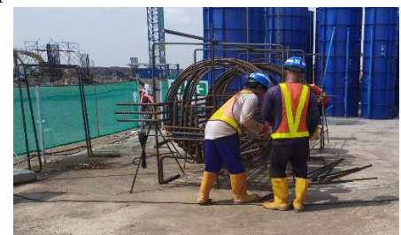
Gambar 5. Perakitan besi tulangan
