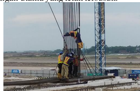
Gambar 4. Pemasangan tulangan joint pertama
