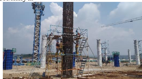
Gambar 6. Pemasangan tulangan joint kedua
