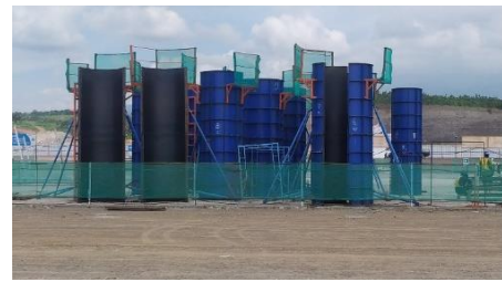
Gambar 3. Fabrikasi bekisting
