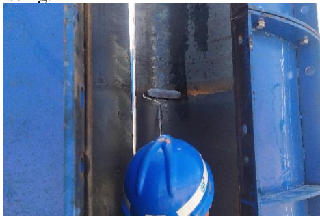
Gambar 9. Bagian dalam bekisting dilapisi minyak bekisting
