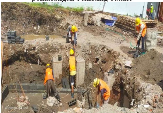
Gambar 3. Pekerja tidak memakai APD saat pemasangan bekisting batako
