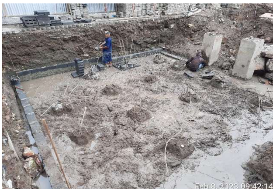
Gambar 3. Pekerja tidak memakai APD saat pemasangan bekisting batako
