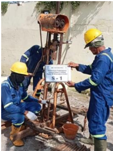
Gambar 3. Dokumentasi Uji Sondir Titik 1
