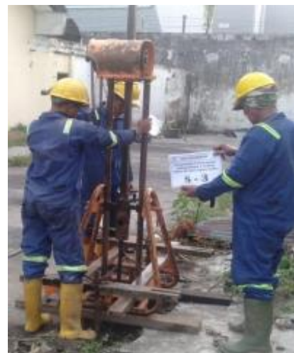
Gambar 7. Dokumentasi Uji Sondir Titik 3
