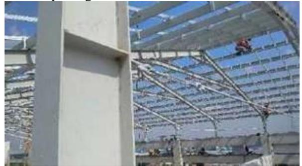
*Gambar 24 Trekstang dan Bracing Kolom*
