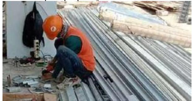
Gambar 18 Pemotongan Baja
