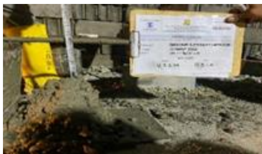
Gambar 4 Tes Slump Beton
