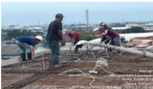
Gambar 3 Pengecoran Dak Atap
