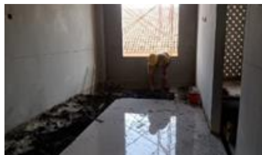
Gambar 7 Pekerjaan Keramik Lantai
