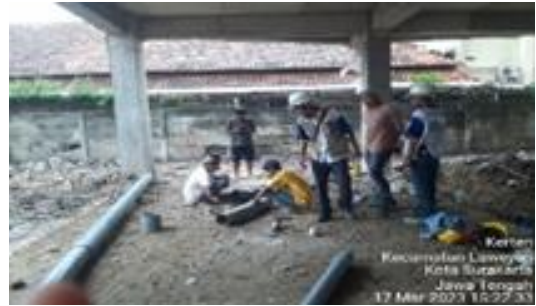
Gambar 13 Instalasi Air Kotor
