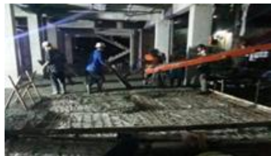
Gambar 2 Pengecoran Lantai Dasar
