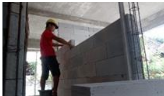
Gambar 6 Pekerjaan Dinding Bata Ringan
