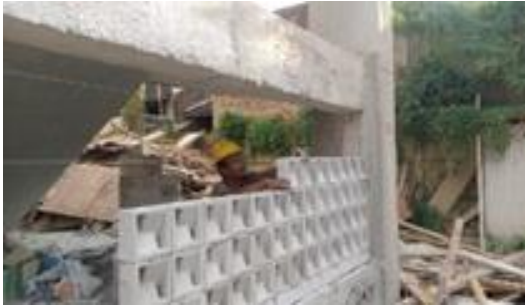
Gambar 9 Pekerjaan Rooster
