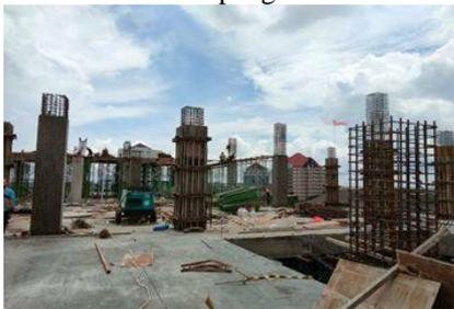
Gambar 25 Pembongkaran Bekisting
