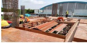
Gambar 3 Pemasangan Bekisting
