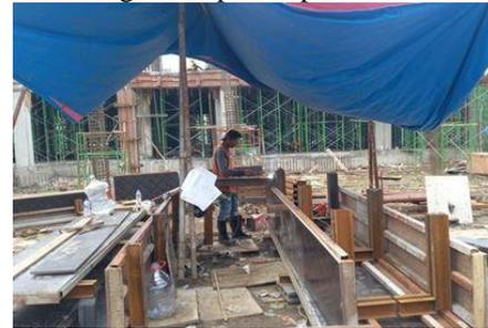
Gambar 22 Pemasangan Bekisting
