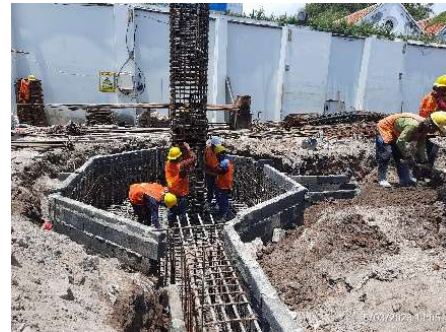
Gambar 4. Pekerja memakai APD lengkap saat pekerjaan pasang besi kolom
