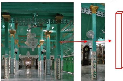
Gambar 22. Tiang penyangga atap ruang utama Masjid Besar Kanjeng Sepuh
