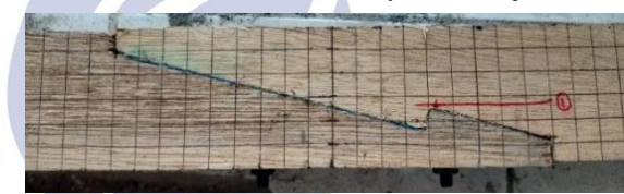
Gambar 13. Kerusakan kayu benda uji E
