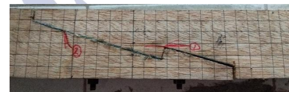
Gambar 12. Kerusakan kayu benda uji D
